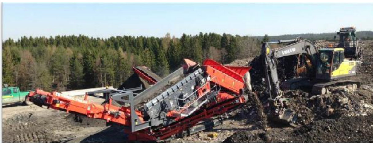
Рис. 7 Грохот, ковшовый экскаватор и фронтальный погрузчик, использовавшиеся в Хёгбиторпе.
